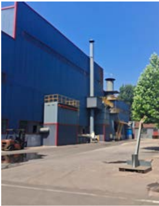
现有项目排放口
